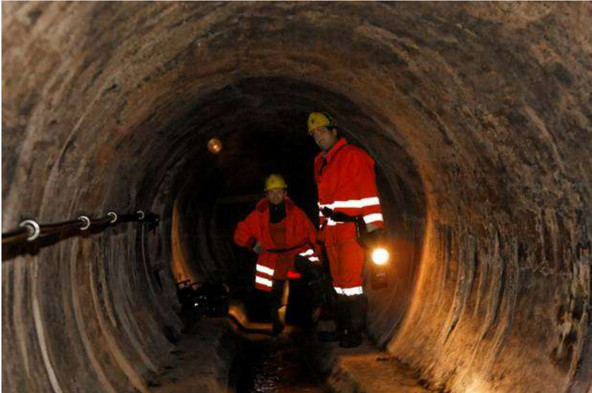
Die Finsternis im Abwasserkanal. Fotos: Joachim E. Röttgers
