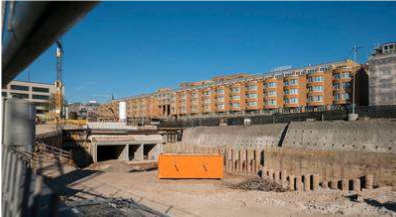
Warten auf Anschluss: Stadtbahnröhren.
