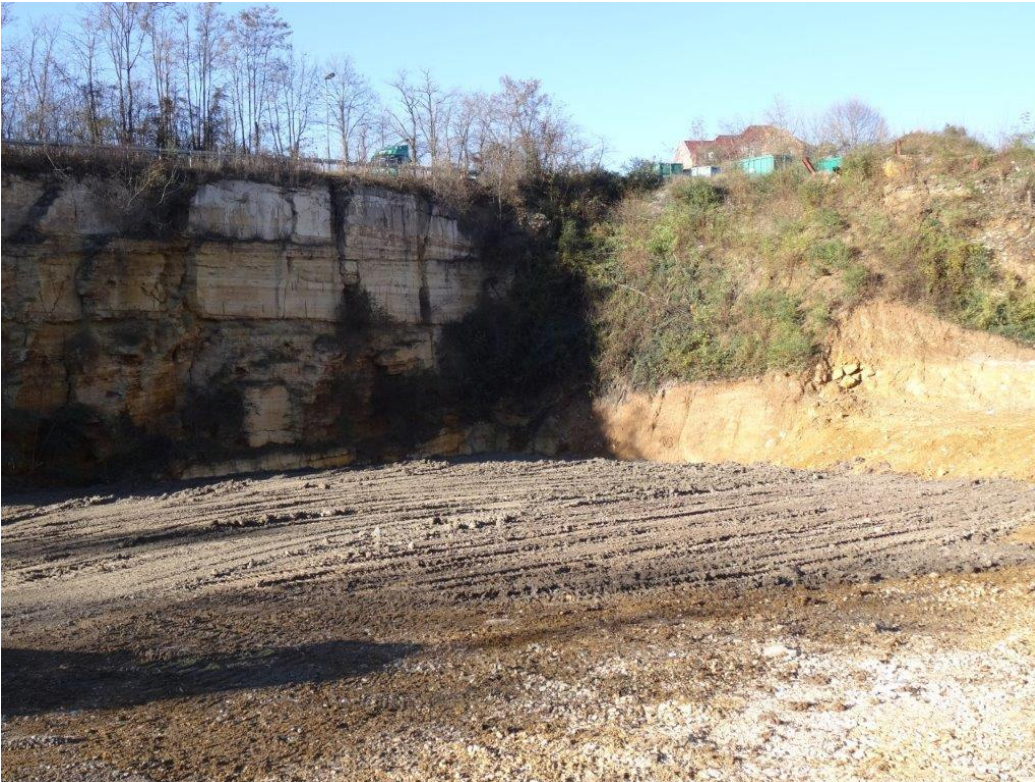
Abb. 1 Einebnung und Verfüllung des Steinbruchs
