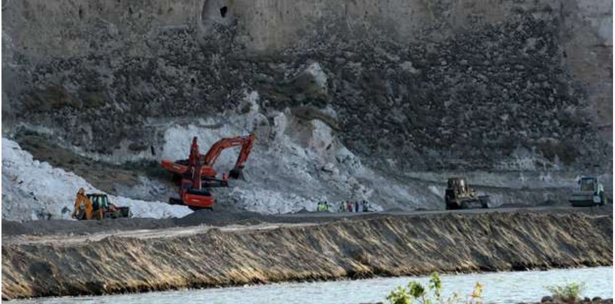
Bauarbeiten am Ilisu-Staudamm im Südosten der TürkeiFoto: reuters
