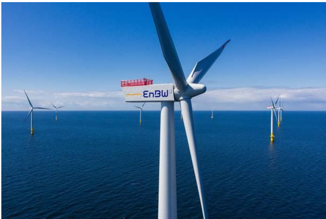
Der Ostsee-Windpark Baltic 2. Foto: EnBW
