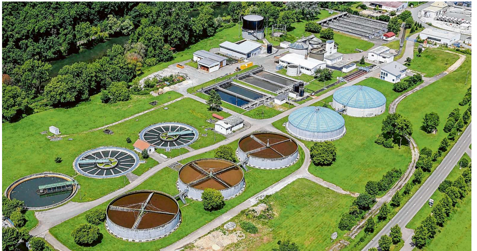
Gegenstand des umstrittenen Cross-Border-Leasings: die Heidenheimer Kläranlage.
